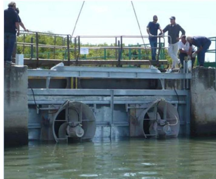
La Conca di navigazione di Gorino, che mette in comunicazione il Po di Goro con la laguna: lavori di installazione delle pompe.
